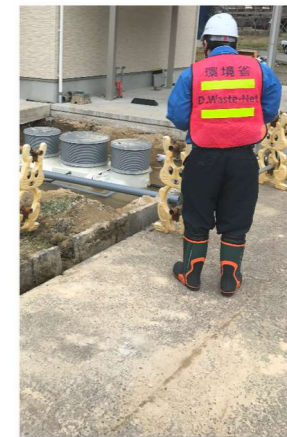
浄化槽工事完了
